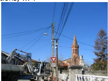
la rue d'Occitanie avant les travaux
